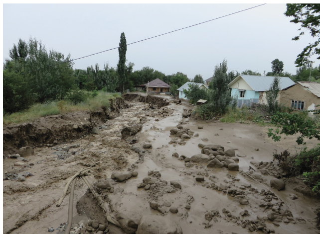
Рис. 3. Разрушения, вызванные селом в пос. Карагайлы в 2015 г. Фото В.П. Благовещенского
