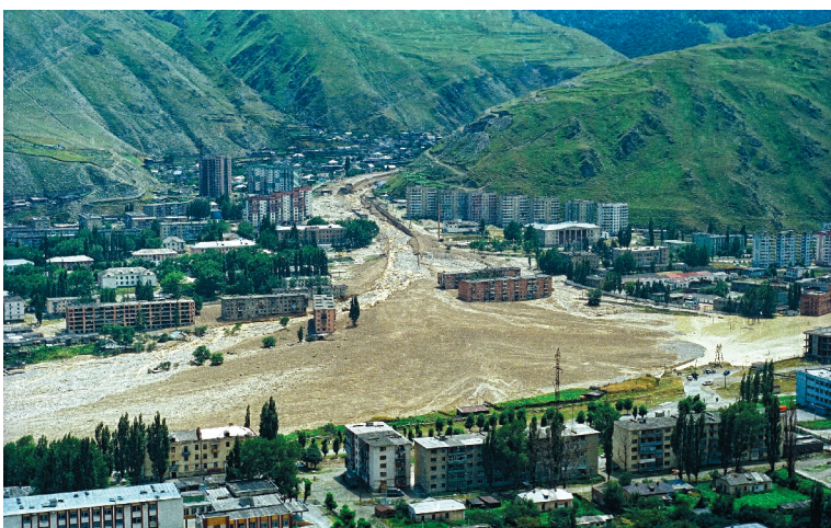
Рис. 6. Заполнение селепропускного канала селевыми отложениями и затопление части г. Тырнауз 18–25 июля 2000 г. (фото А.А. Алейникова, 25 июля 2000 г.)
