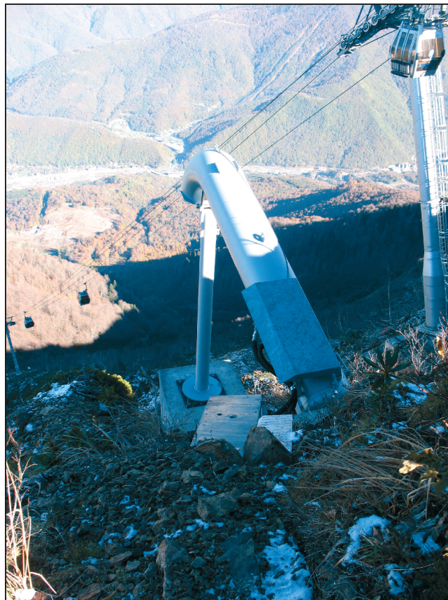
Рис. 4. Эксплодер GAZEX Fig. 4. GAZEX exploder
